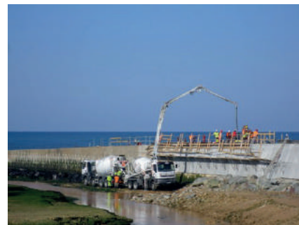
Illustration 2 : Travaux : réfection des épis
