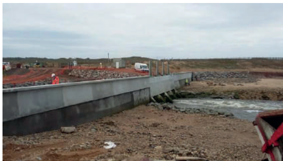
Illustration 1 : réfection du barrage
