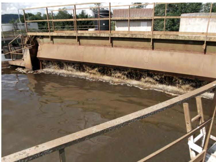
Pont brosse sur bassin d'aération laiterie CFVA - crédit photo "Laiterie CFVA"
