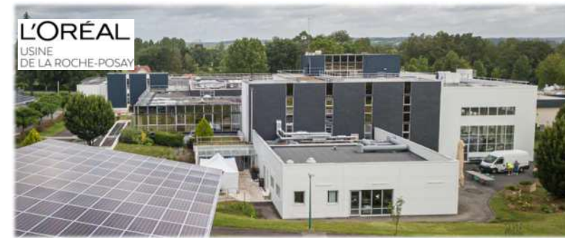
120 personnes, 9 000 m 2 construits Sources LRP à 1 Km
