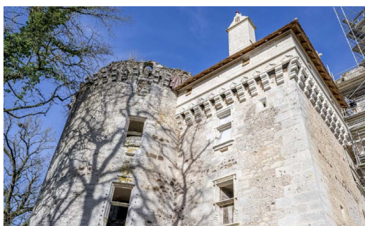
Tour Sud-Ouest du château de l'Herm à Rouffignac-Saint-Cernin-de-Reilhac © Fondation du patrimoine_MyPhotoAgency_Norman Lewis
