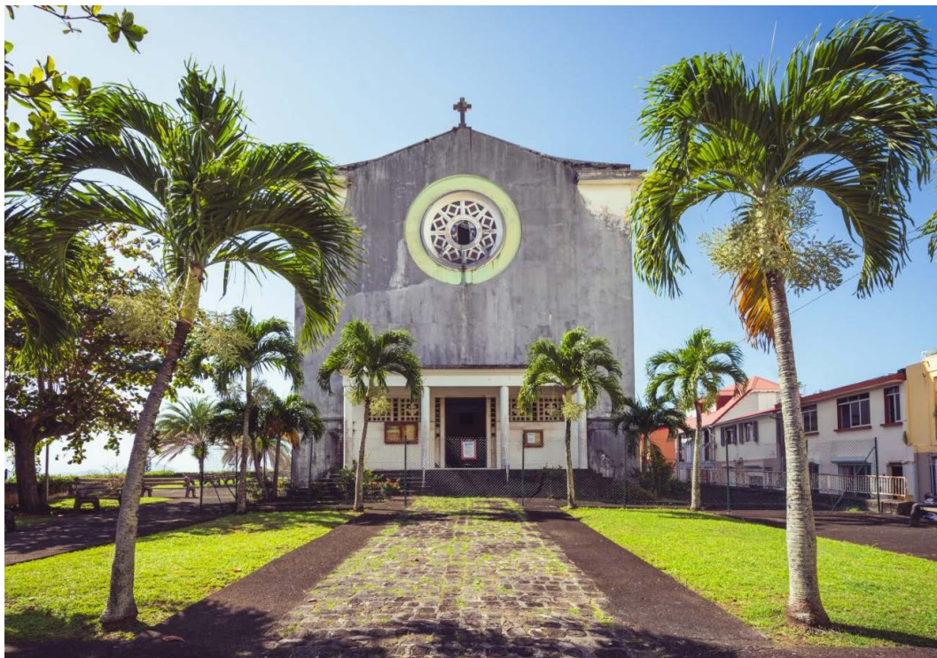
Église Notre-Dame de l'Assomption à Trois-Rivières © Fondation du patrimoine_MyPhotoAgency_Ismael Verdol
