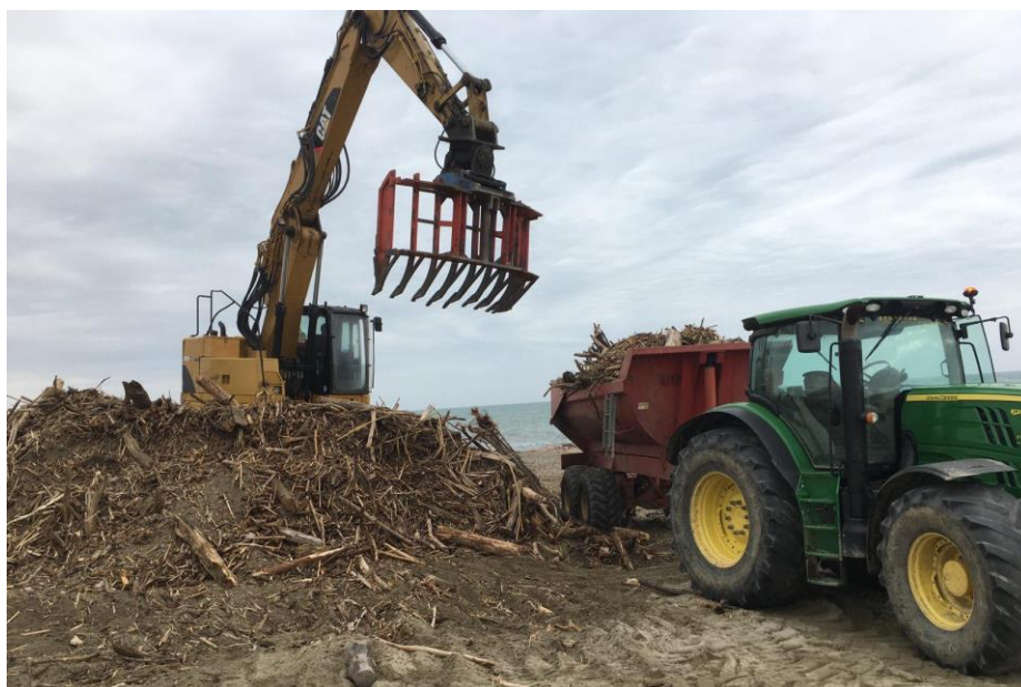
Figure 48 : Godet fléco utilisé par la société Travaux des Aspres pour un chantier de ramassage de bois flottés sur une plage d’Occitanie (SARL Travaux des Aspres, 2020)
