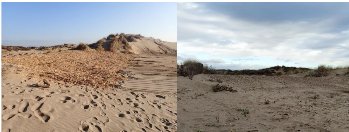
Figure 51 : Bourrelet en broyat de bois flotté de Sérignan, en février 2019 à gauche et en octobre 2020 à droite (EID Méditerranée)
