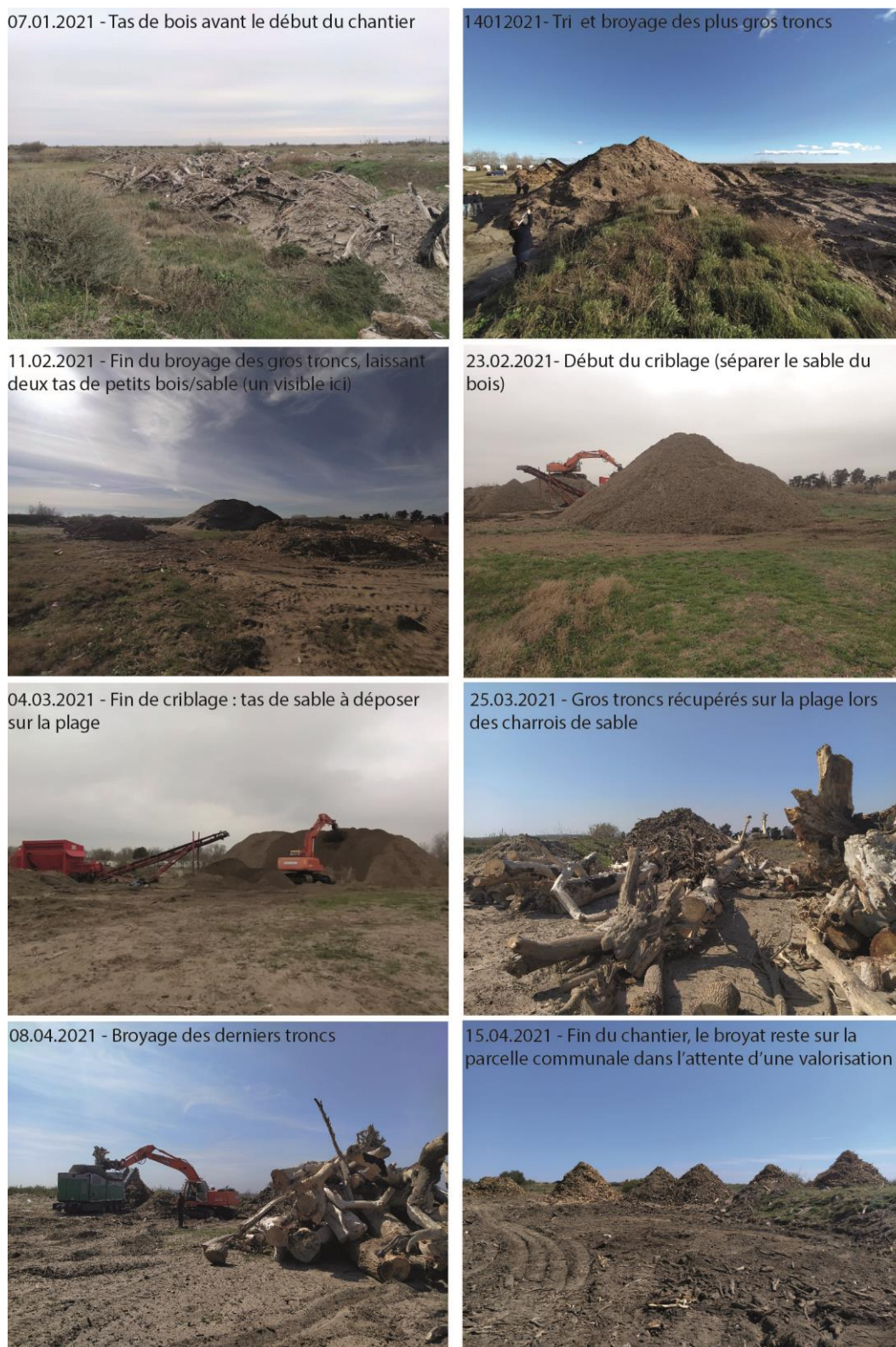
Figure 7 : Déroulement du chantier de broyage des bois flottés de la tranche optionnelle à Fleury-d'Aude de janvier à avril 2021 (EID Méditerranée, 2021)
