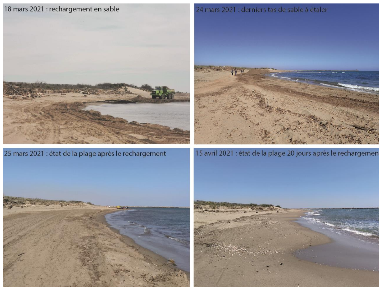
Figure 6 : Rechargement de la zone d’érosion la plus marquée sur la plage des Cabanes de Fleury avec le sable issu du chantier des bois flottés (EID Méditerranée, 2021)
