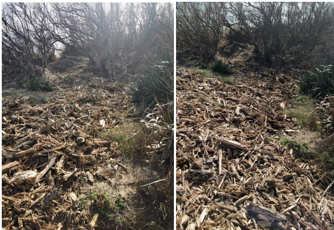
Figure 52 : Comblement d'une faiblesse dunaire par du broyat de bois flotté local grossier, à gauche le 26 janvier et à droite le 11 février 2021 (EID Méditerranée, 2021)
