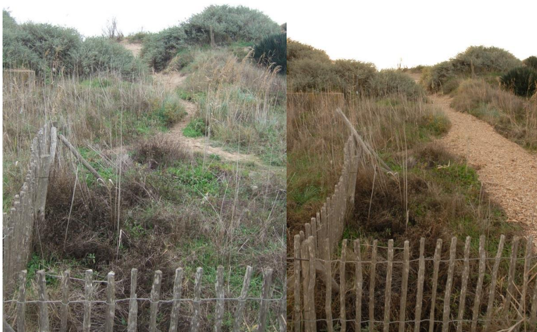
Figure 16 : Chemin d'accès à la plage de Sérignan, en janvier 2016 et en février 2016 après le reprofilage et la pose de broyat de bois flotté (EID Méditerranée, 2016)
