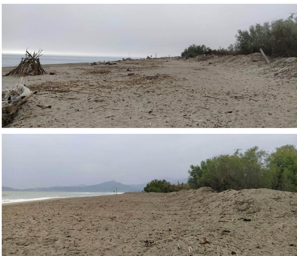
Figure 33 : Etat de la plage d'Elne le 30 mars 2021 avant le début du chantier (en haut) et le 27 avril 2021 après la fin du chantier (en bas) : les plus gros troncs ont été retirés de la plage et du bourrelet sableux qui a ensuite été nivelé (EID Méditerranée, 2021)
