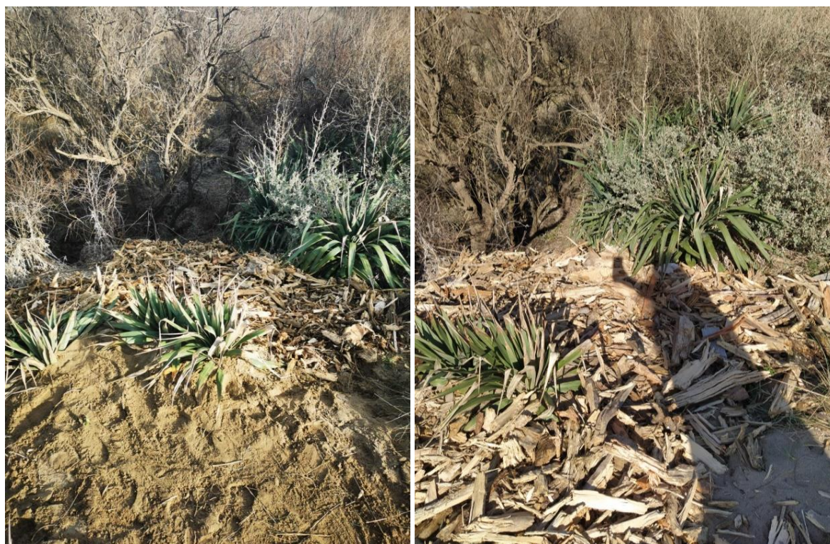
Figure 53 : Positionnement de broyat de bois flotté grossier sur une faiblesse dunaire en cours sur la photographie de gauche du 26 janvier et plus tard sur la photographie de droite le 11 février 2021 (EID Méditerranée, 2021)
